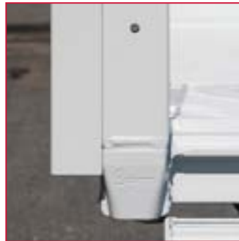
Konischer Pfosten mit Befestigungsschraube
